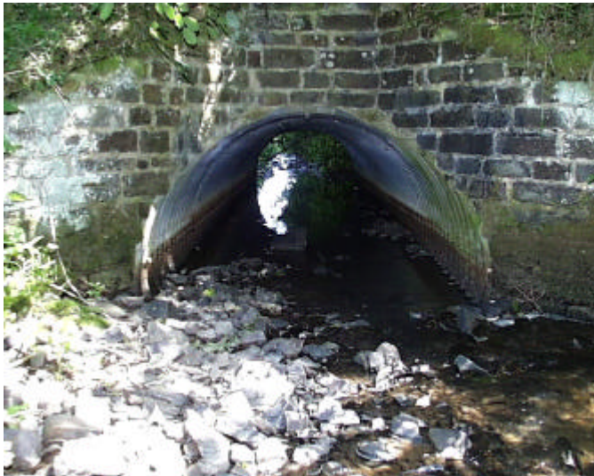
Bild 4: Durchlass in Abschnitt 91
