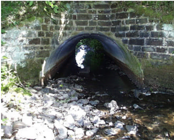
Bild 4: Durchlass in Abschnitt 91
