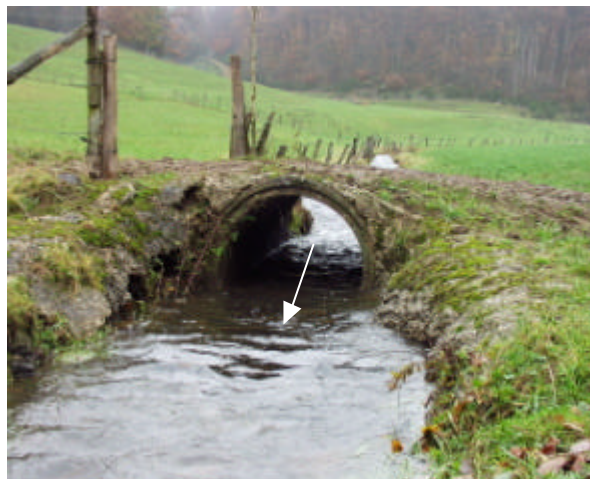
Bild 7: Abschnitt 27 Rohrdurchlass NW 1000
