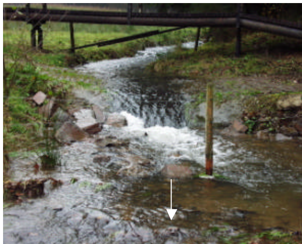
Bild 6: Abschnitt 25 gepflasterte Furt mit Sohlabsturz
