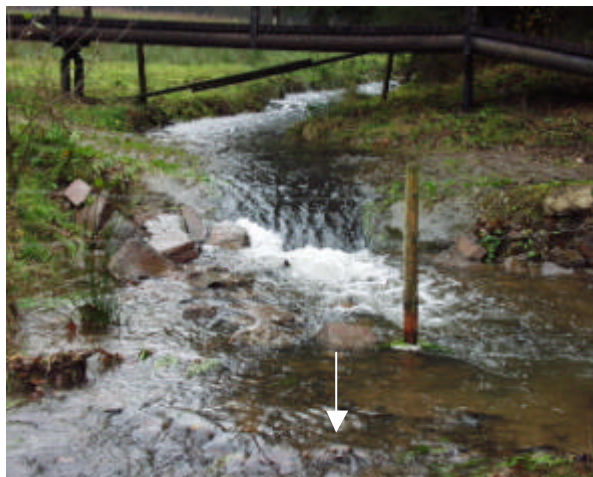
Bild 6: Abschnitt 25 gepflasterte Furt mit Sohlabsturz
