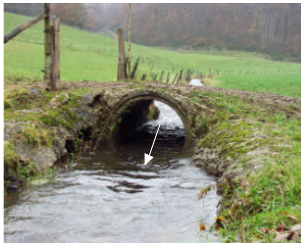
Bild 7: Abschnitt 27 Rohrdurchlass NW 1000
