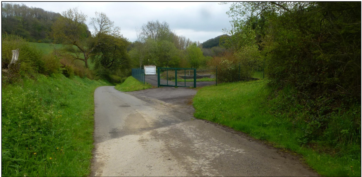
Abbildung 23: Ansicht Kläranlage Ringhuscheid
