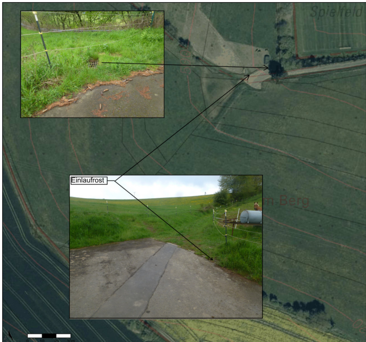
Abbildung 35: Lage und Erscheinungsbild Einlaufbauwerke
