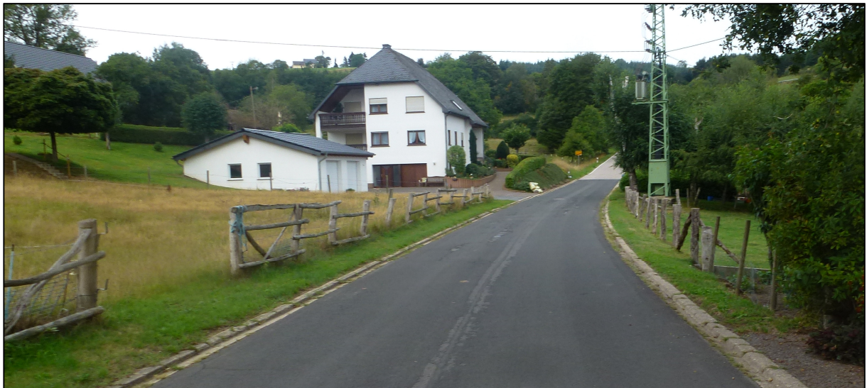
Abbildung 29: Ansicht Senke in der Ringhuscheid-Hauptstraße mit vorhandenen Hochborden
