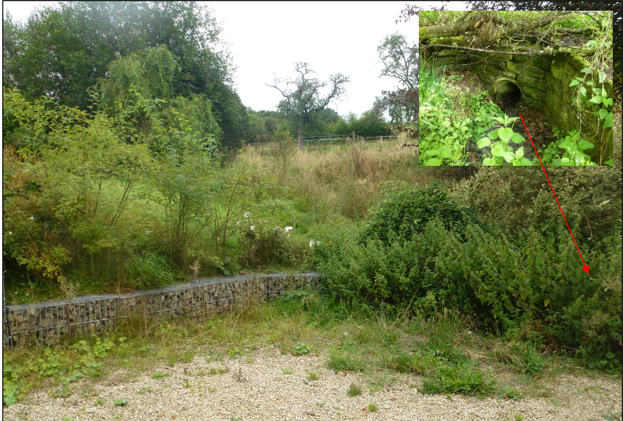
Abbildung 24: Blick in die Tiefenlinie entgegen der Fließrichtung und Einlaufbauwerk
