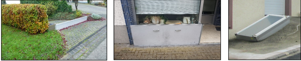
Abbildung 19: Beispiele von Objektschutzmaßnahmen (mobile Steckelemente, Dammbalkensysteme, Abdichtungen)
