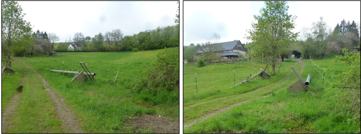
Abbildung 37: Ansicht der Wiesenflächen neben der Zufahrt zur Kirchstraße 5 von der Hauptstraße Neben der Zufahrt befindet sich ein Einlaufbauwerk in die verrohrte Fassung der Tiefenlinie vom Sportplatz, in dem zusätzlich das Wasser der Straßenentwässerung der K61 gefasst wird. In der nachfolgenden Abbildung sind die Fließwege, Senken und vorhandenen Entwässerungseinrichtungen übersichtlich dargestellt.
