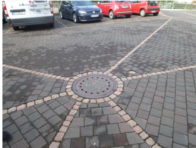
Abbildung 50: Schachtdeckel zum Bachkanal
