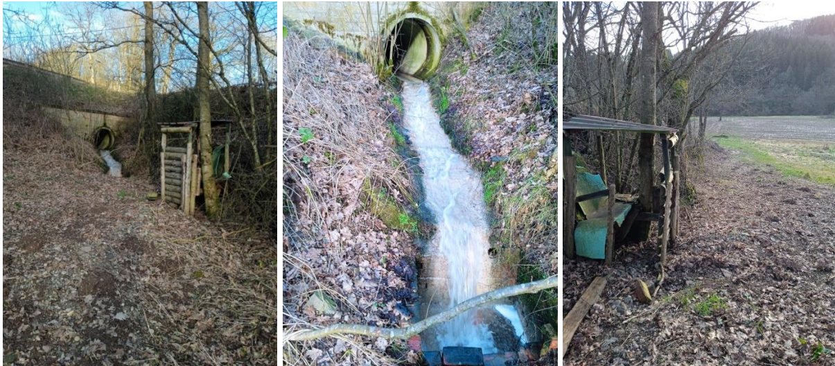
Abbildung 92: Auslauf der Verrohrung der Tiefenlinie „In der Dell“ hinter der L 12
