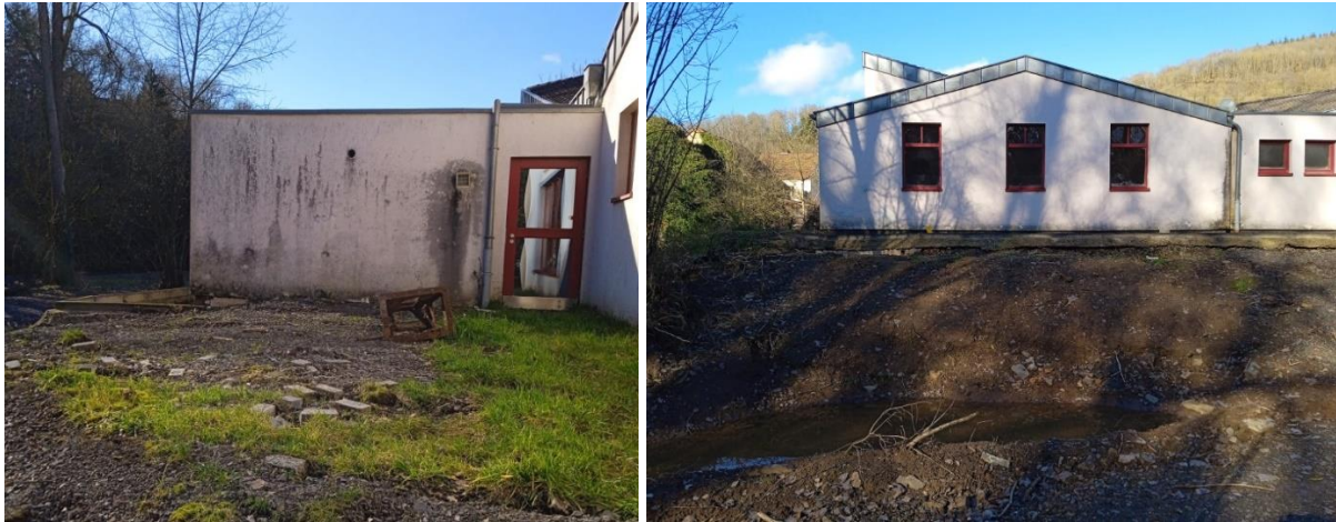
Abbildung 39: Anbau des vom Julihochwasser 2021 beschädigten Dorfgemeinschaftshauses
