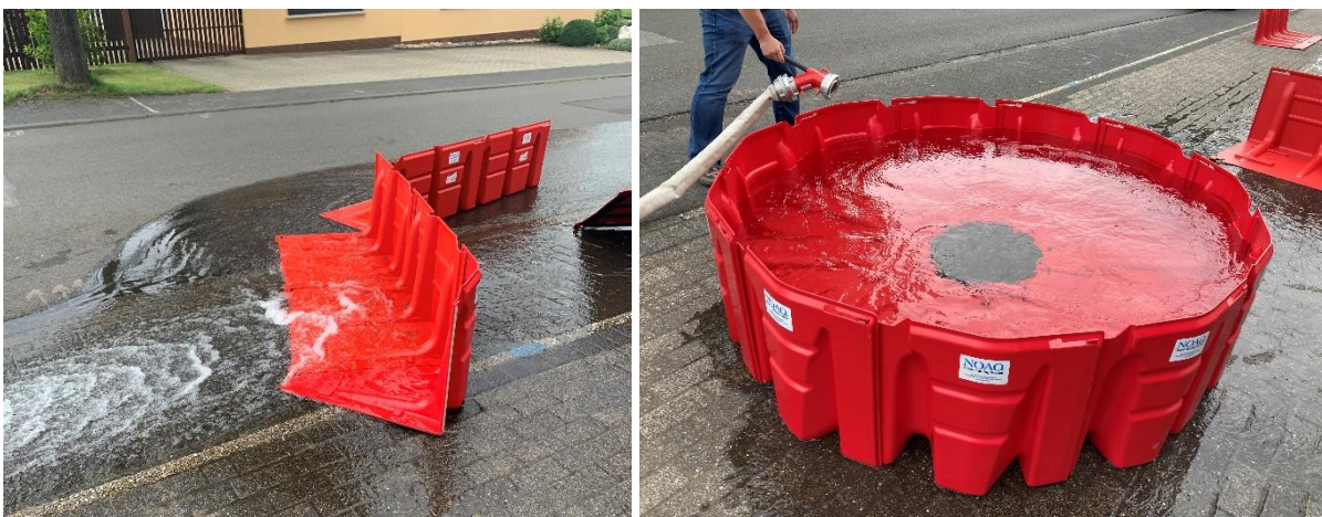
Abbildung 53: mobile Elemente zur Lenkung des Abflusses
