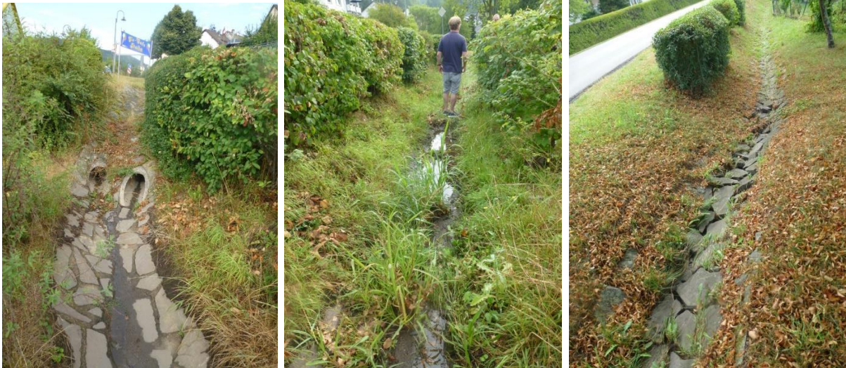
Abbildung 79: offene Entwässerung im Bereich der Luxemburger Straße L 10
