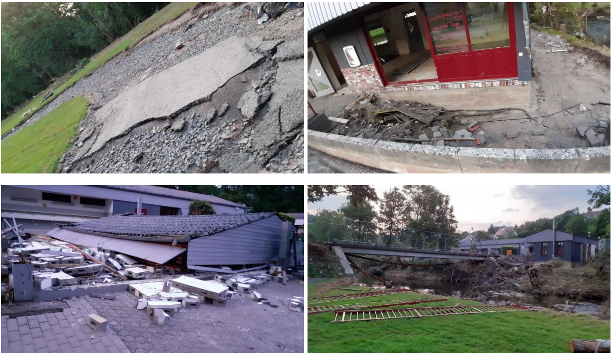
Abbildung 78: Auswahl an Schadensfotos nach dem Julihochwasser 2021
