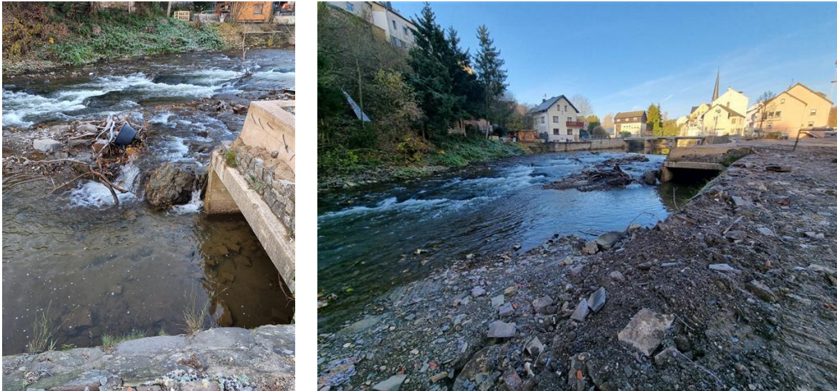
Abbildung 47: Weierbachmündung vor der Räumung
