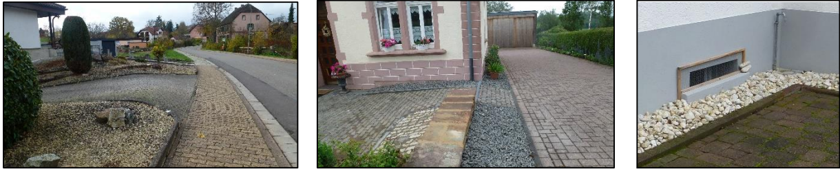
Abbildung 24: Beispiele von Objektschutzmaßnahmen (Überbogen, Geländemodellierungen, Aufkantung am Kellerfenster)
