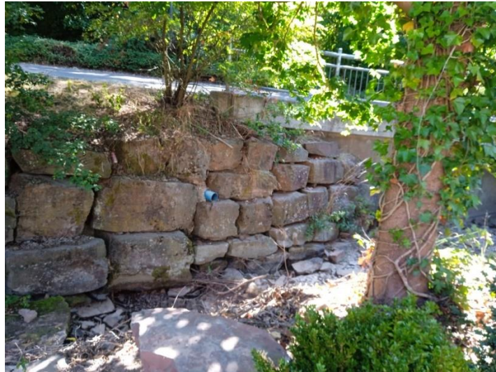
Abbildung 45: Brücke über den Weiherbach am Scheuerweg
