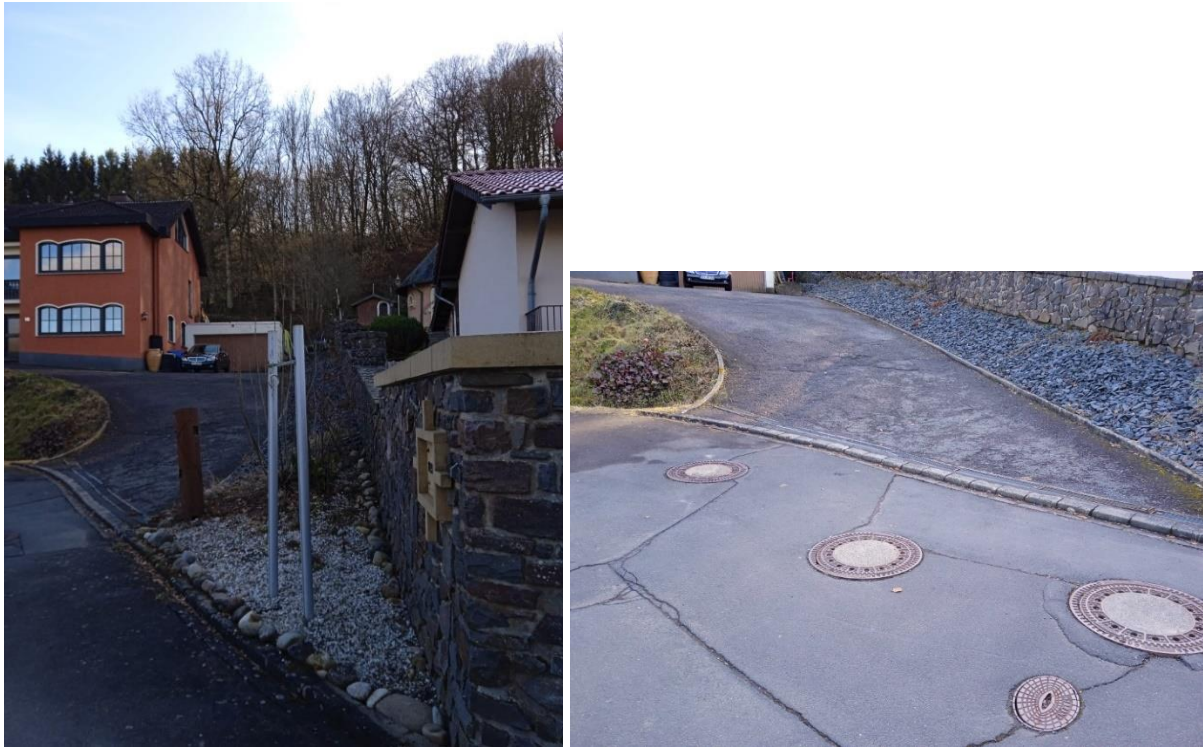
Abbildung 70: Tiefenlinie Bornwiese mit Schachtdeckel der Verrohrung
