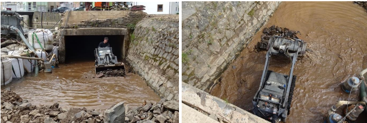
Abbildung 48: Räumung Rechteckkanal Weierbach
