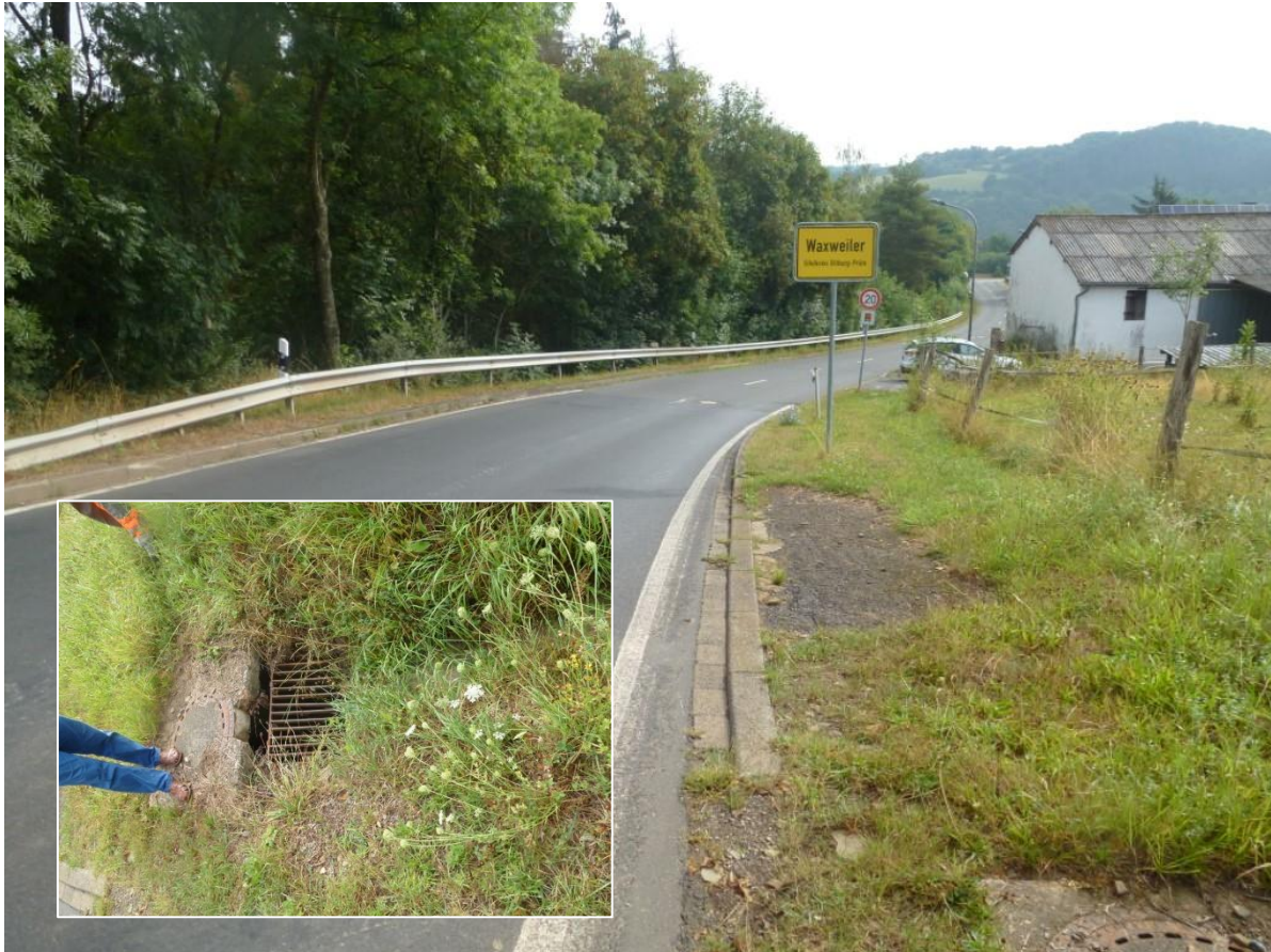
Abbildung 67: Gerhard-Faber-Straße (K 137) mit Einlaufbauwerk am Ortseingang
